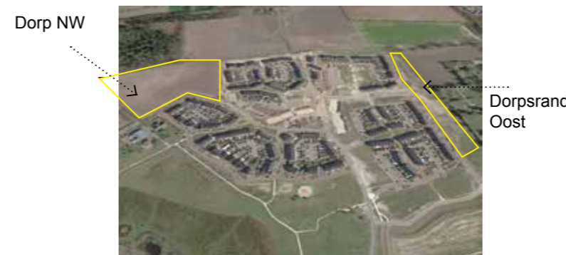
Dorp Steenbrugge in aanbouw stvz 2020
