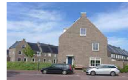
kopgevel als voorgevel met voordeur en tuinmuur
