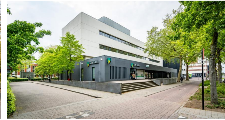
DE ABN AMRO BANK UIT 1975, H.A. MAASKANT
