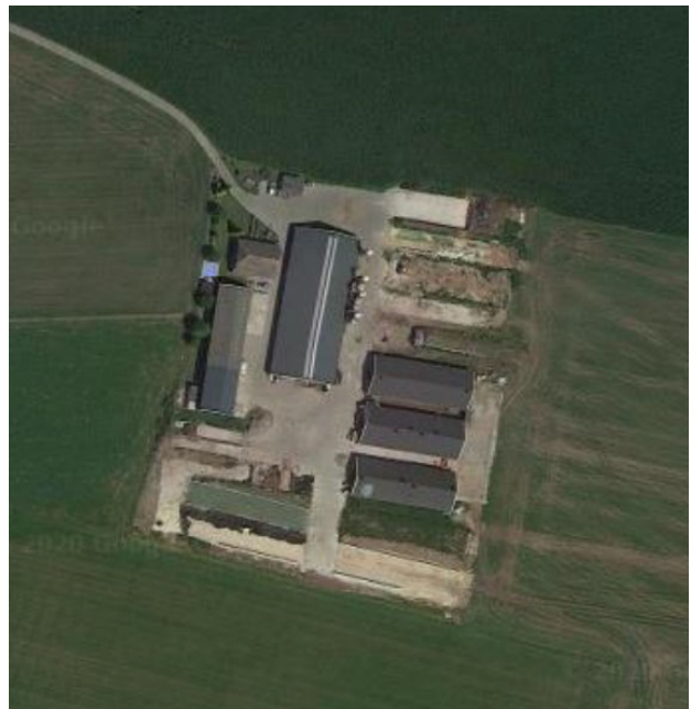
Figuur 2.1: Bestaande situatie Raalterweg 30 (bron: google maps)
