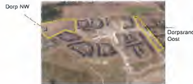
Dorp Steenbrugge in aanbouw stvz 2020
