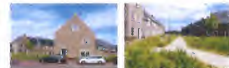
kopgevel als voorgevel met voordeur en tuinmuur
