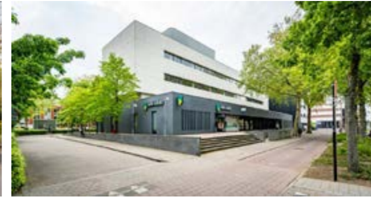
DE ABN AMRO BANK UIT 1975, H.A. MAASKANT
