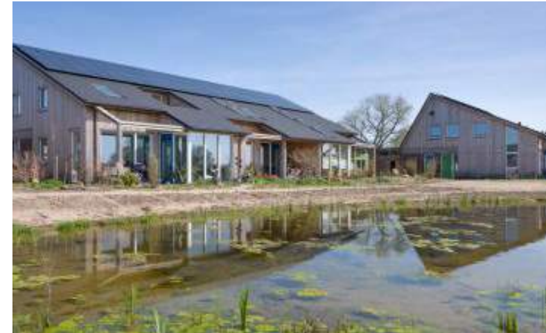
ECOLOGISCHE WONINGEN VRIENDENERF OLST - HUNEBOUW
