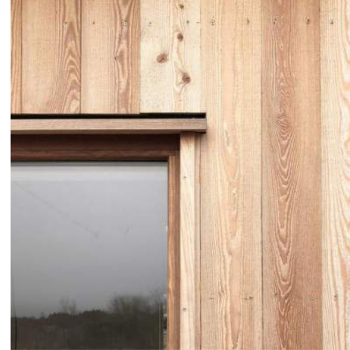
thermisch gemodificeerde houten gevel
