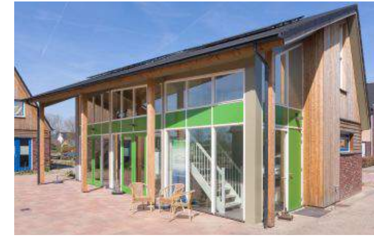
GEMEENSCHAPSGEBOUW VRIENDENERF OLST - HUNEBOUW
