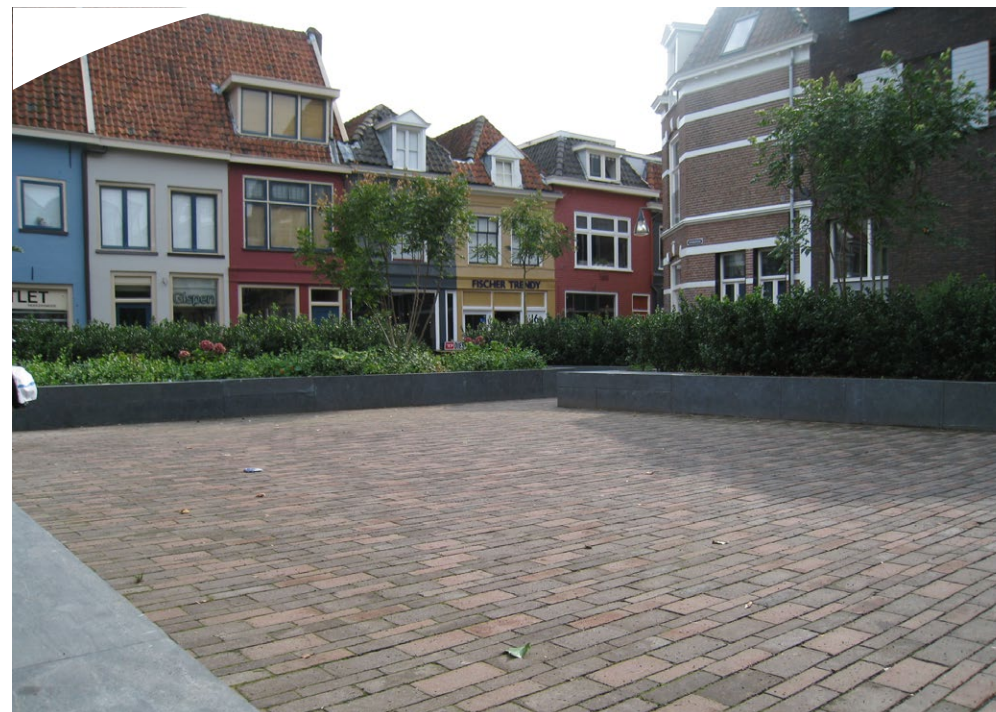
Foto: Waterpasserende verharding Lamme van Dieseplein.
