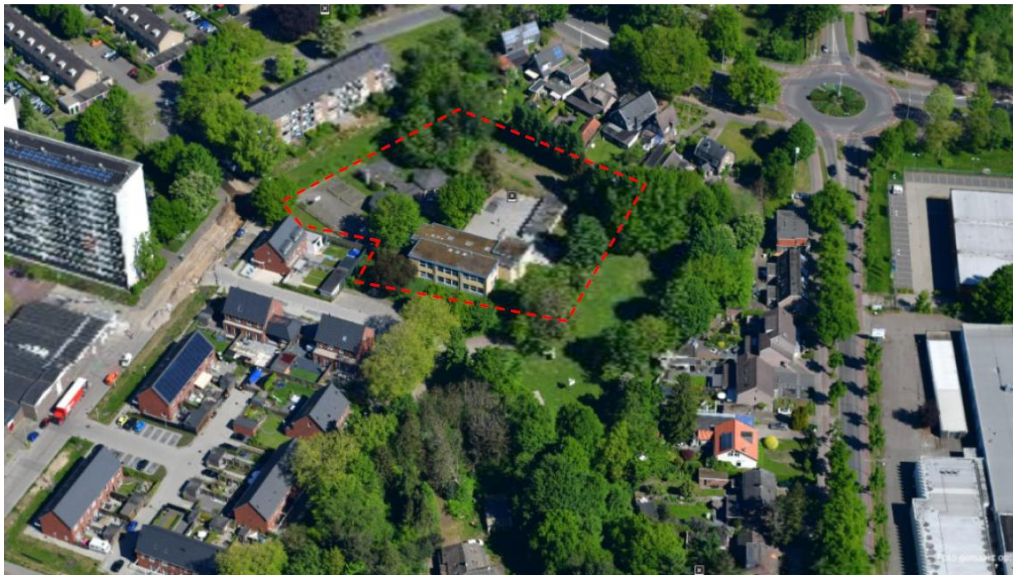
Afbeelding: luchtfoto locatie Wittenstein
