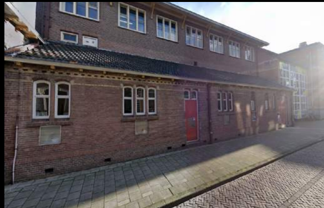
Kans meer openen van de gevel gymzaal
