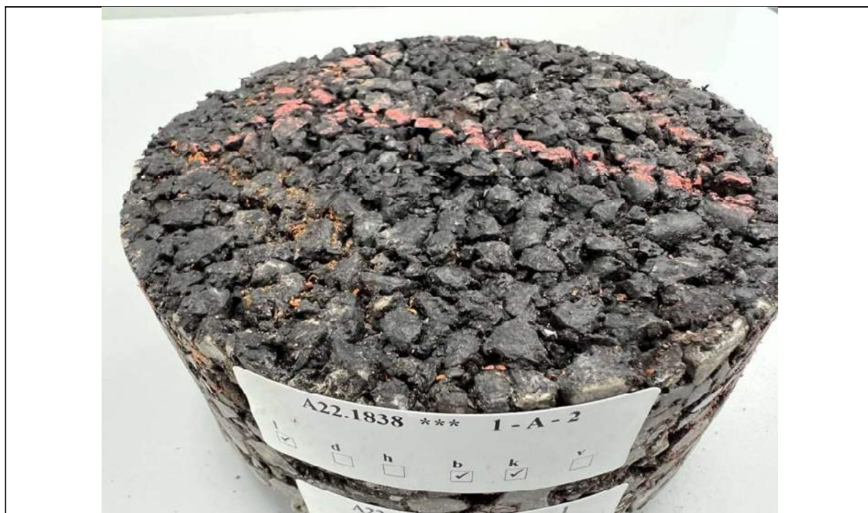
Bovenkant asfalt toplaag, kern 1A
