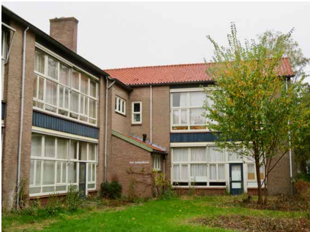
Afb. 32 - Zuidgevel met uitstek voor twee lokalen (beneden het overblijflokaal) en in de oksel de waskeuken uit 1975.
