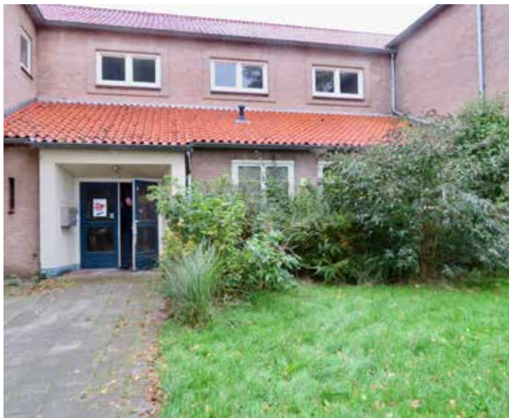
Afb. 21 - Uitbouw voorgevel (zuid) met entree en kamers schoolhoofd.
