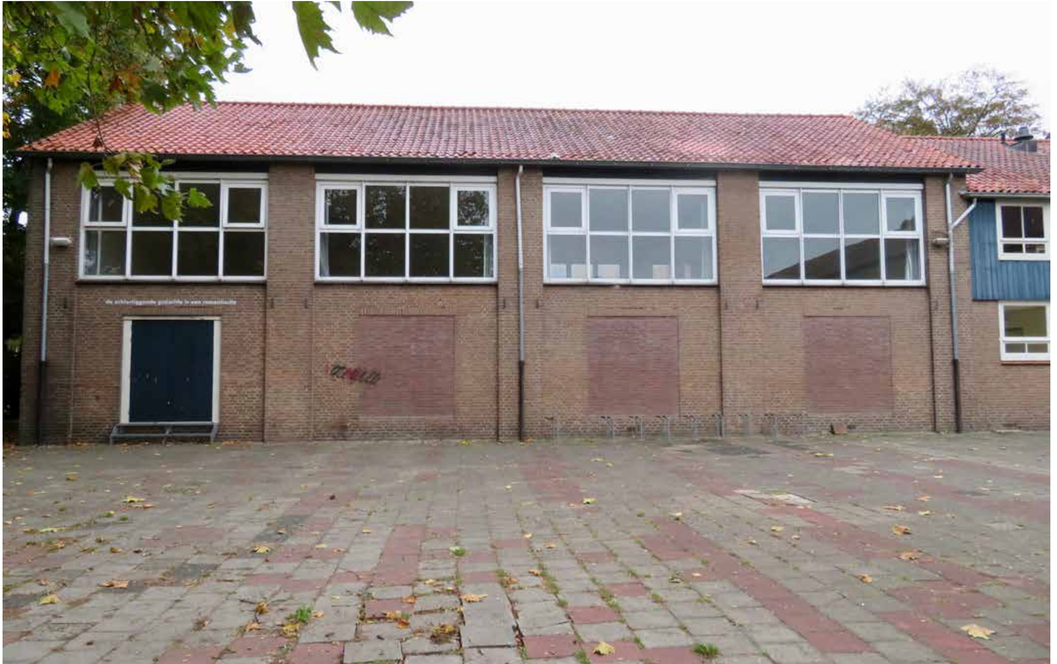
Afb. 31 - Westgevel gymzaal: hoge plint, dichtgezette vensters, rechts de ophoging in de aansluiting aan het hoofdvolume.
