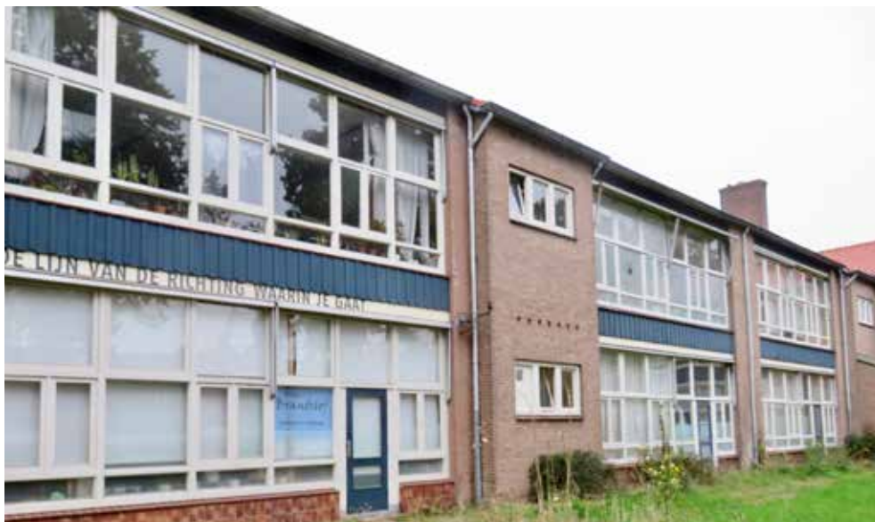
Afb. 35, 36 - Verlenging naar west uit 1977-78. Zuidgevel en aansluiting in het interieur.
