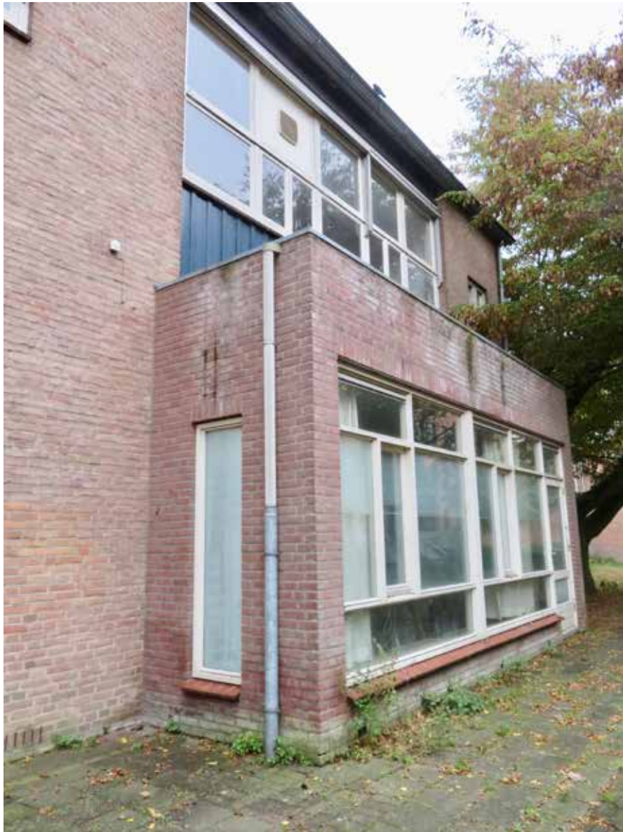
Afb. 37 - Aanbouw erker aan de oostgevel uit 1998.
