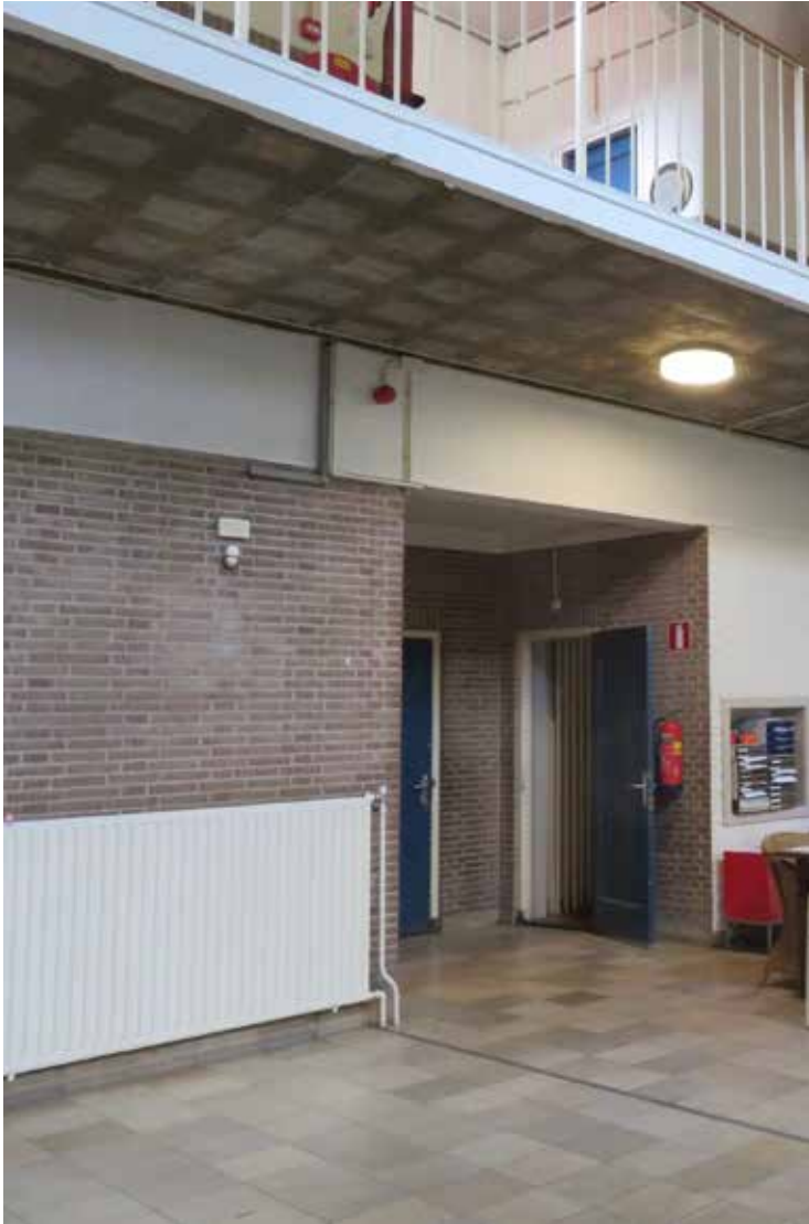
Afb. 16 - Interieur: deel van de hal met metselwerk, vloertegels van kalksteen.
