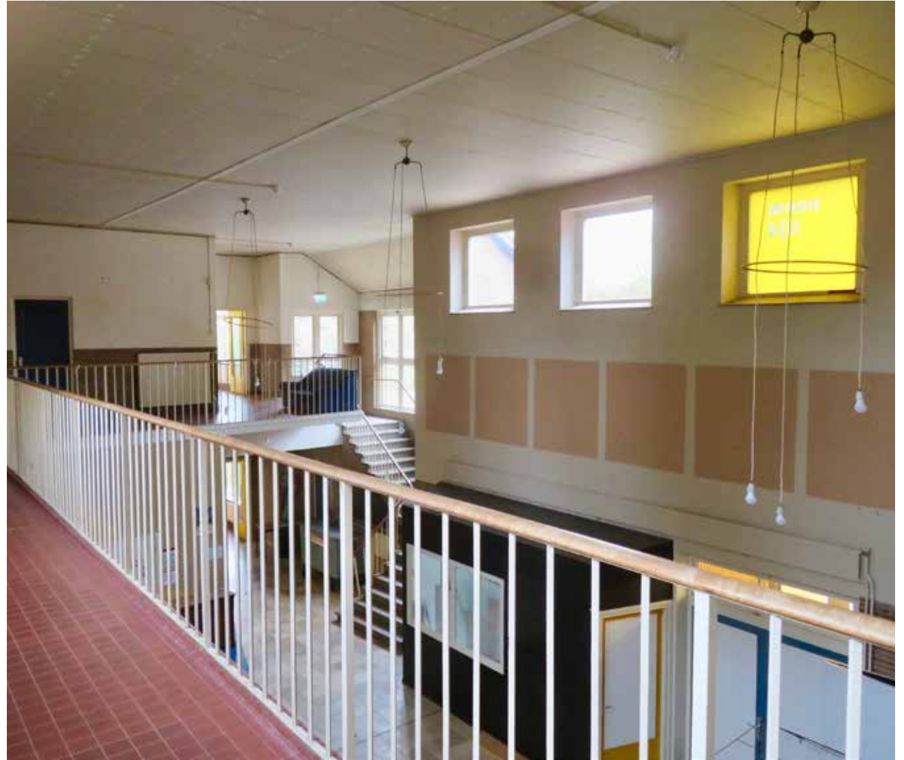
Afb. 17 - Interieur: de galerij in de hal – dhg vloertegels, balustrade in staal, leuningprofiel hout – overzicht naar de trap.
