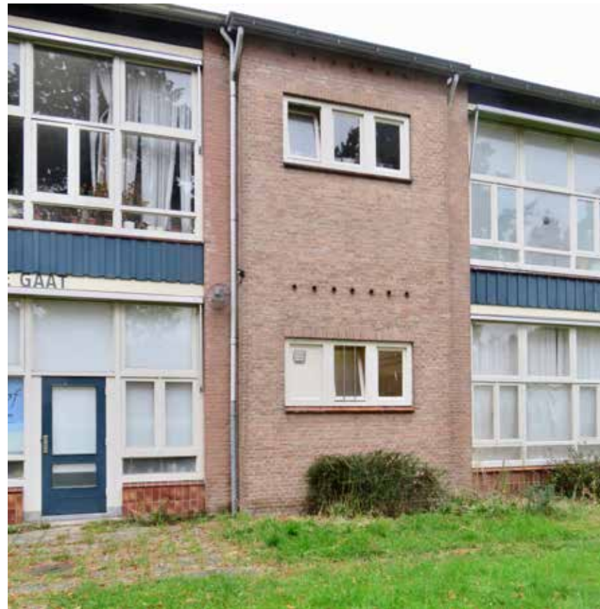
Afb. 28 - Zuidgevel: ingemetselde cilinders, bakstenen voorsprongen voor toiletten en garderobes, gebouwhoge lokaalpuien met verdiepings-scheiding in houtbekleding.
