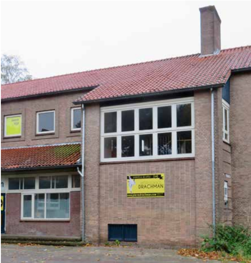
Afb. 27- Noordgevel: trappenhuis met stapelverband, raamomlijstingen halramen, volgebouwde portiek van de deuren tussen hal en speelplaats.
