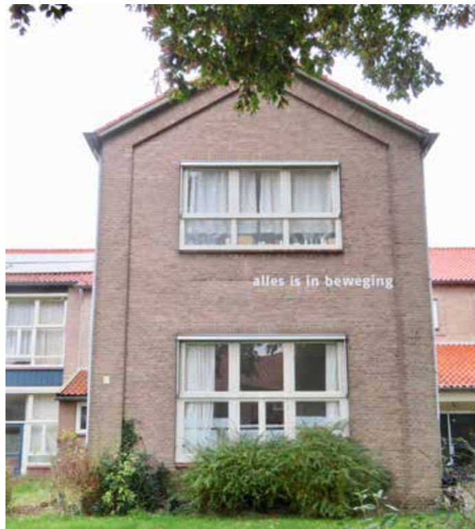
Afb. 25, 26 - Hoeklisenen in het metselwerk gaan als rollaag door langs de dakranden.
