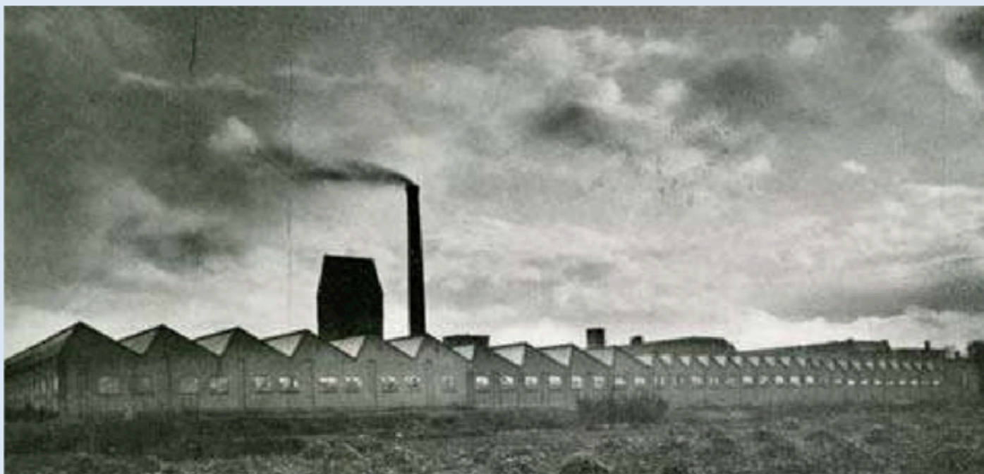
Vooroorlogse (ongedateerde) foto met daarop goed zichtbaar de contouren van de Watertoren, die voorheen nog van een afgeknot zadeldak was voorzien.
