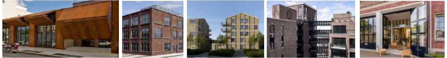
plot 7, stoere industriële architectuur, een ensemble van bouwdelen met een levendige plint met entrees en voorzieningen en/of woonoriëntatie
