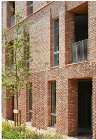
Plastiek in gevel door terugliggend metselwerk
