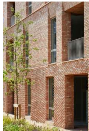
Plastiek in gevel door terugliggend metselwerk
