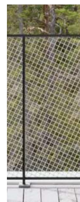
stalen balustrade met netvulling
