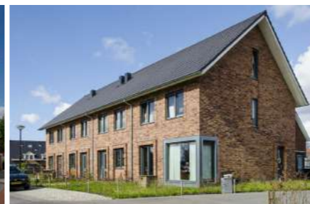
accenten in metselwerk
