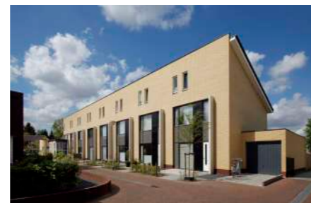
strakke architectuur & gele gevelsteen
