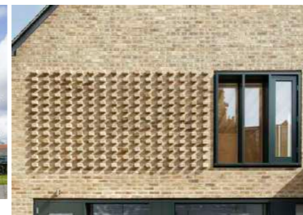
accenten in het metselwerk
