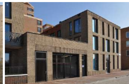
verschillende metselwerk verbanden
