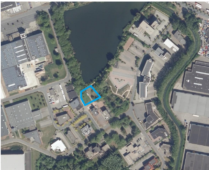
Luchtfoto bestaande situatie plangebied (bron: ruimtelijkeplannen.nl)
