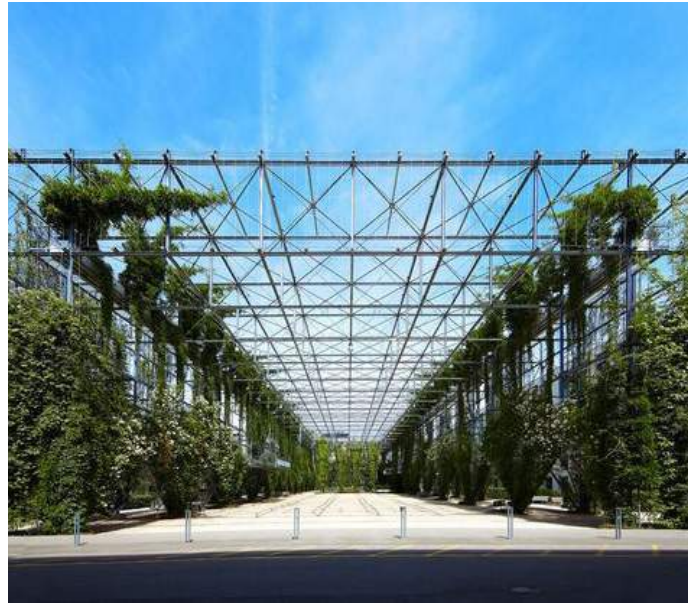
2. Smeets plein met begroeiende constructie
