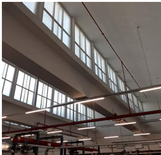
Gebouw 1951: Betonnen sheddak
