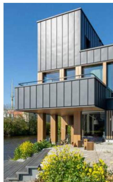
CPO De nieuwe linie; Europark, Groningen Architect: Onix NL Bouwbedrijf: Kolthof BV
