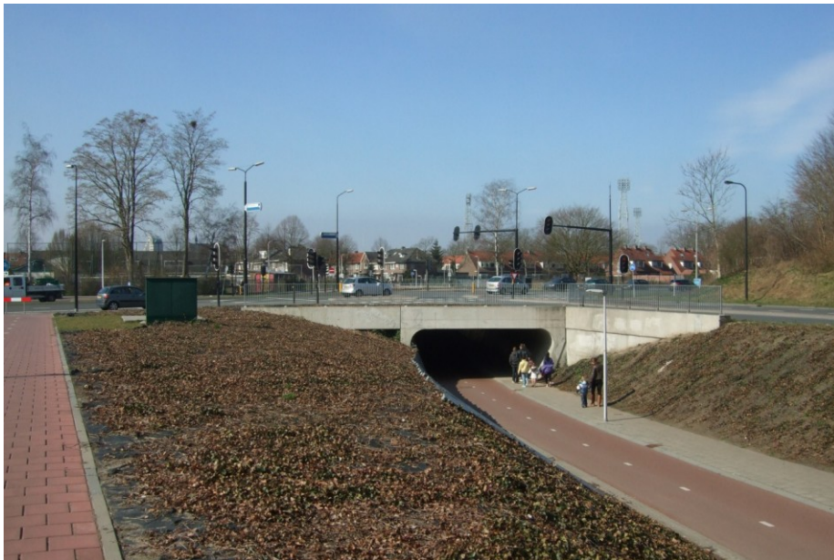
fietsstunnel Henri Dunantlaan: veilige kruising tussen fietsroute en hoofdweg
