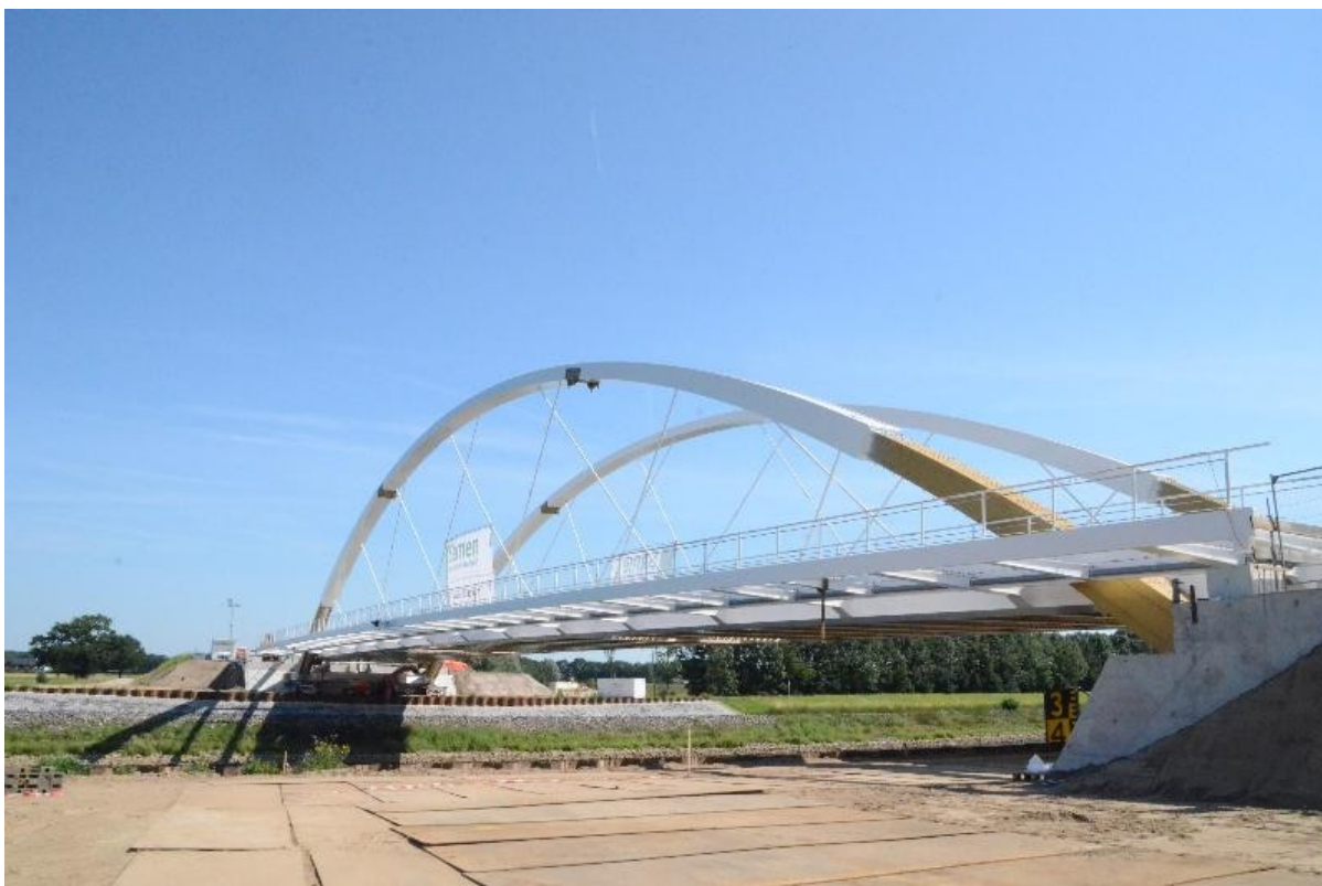
nieuwe brug over Twentekanaal in N348 bij Zutphen (bron: RTV Oost 2012)
