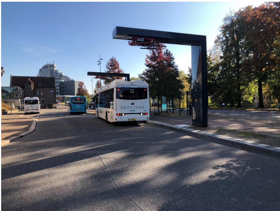
Figuur 5: Ultrasnelladen voor lijnbussen op het busstation in Deventer
