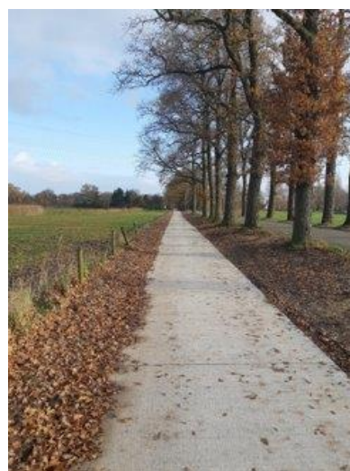
Figuur 18: beton fietspad langs de Oerdijk
