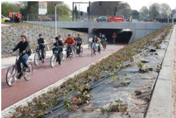
Figuur 2: Fietstunnel Henri Dunantlaan
