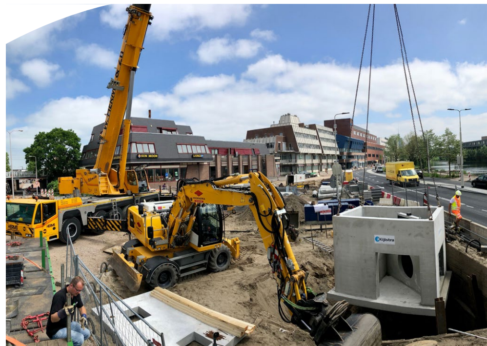
Foto: werkzaamheden Brinkgrevertunnel.
