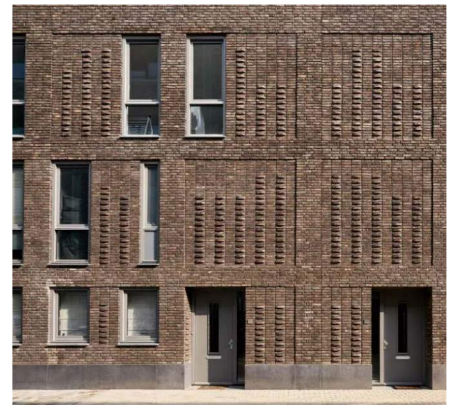
verrijkingen door bijzonder metselwerk
