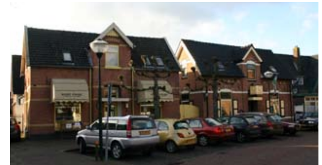
Karakteristieke (winkel)panden in het centrum van Bathmen. Elk pand heeft een individuele uitstraling met een symmetrische opbouw en middenrisaliet, doorlopend in een dakkapel
