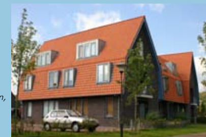
Referentiebeeld voor bebouwing van 3 lagen, de bovenste lagen zijn als kapverdieping uitgevoerd
