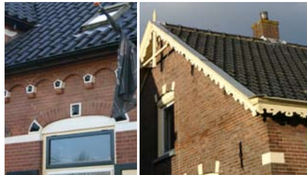
Kenmerkende detaillering in het metselwerk en afwerking van de dakrand
