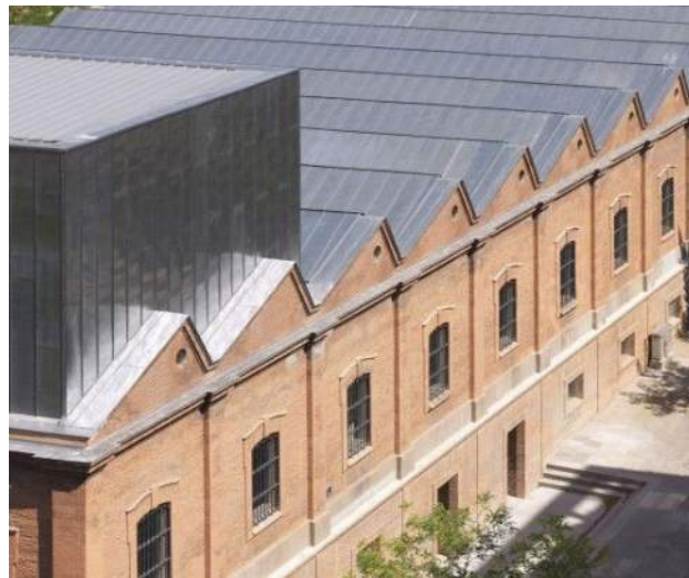
Entrees tekenen zich af in de gevel en zijn direct herkenbaar
