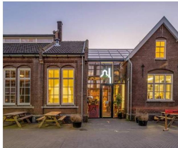
Referentie: Vakwerkhuis - Delft. Behoud van industriële gevel
