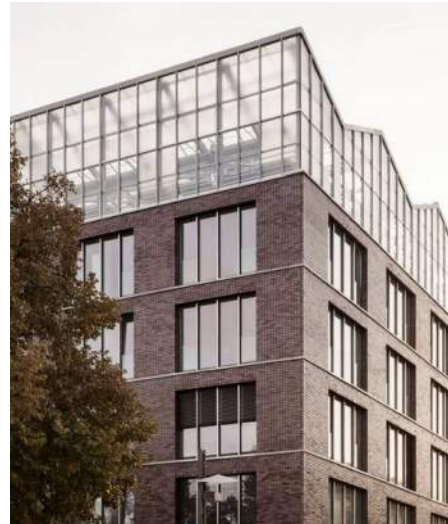
Glazen opbouw als verwijzing naar industriële architectuur
