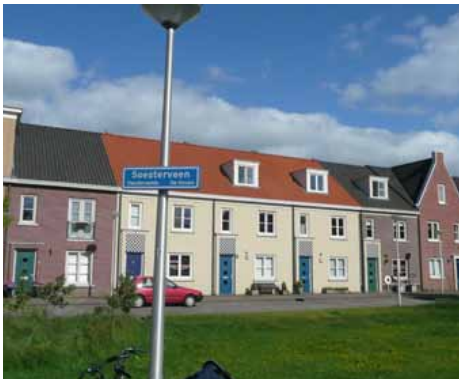
variatie in straatbeeld door verschillend materiaalgebruik
