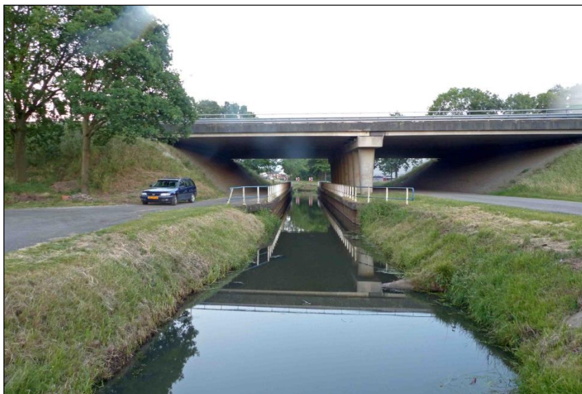
Figuur 3-3. De passage van de Grote Wetering onder de A1. Deze watergang vormt een potentiële vliegroute voor meerdere soorten vleermuizen, waaronder de watervleermuis ( Myotis daubentonii ). Foto: R.M. Koelman.
