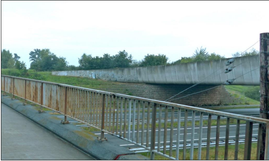
Figuur 5-5. Op de voorgrond de fietsbrug, op de achtergrond het ecoduct over de A1. Foto: R.M. Koelman.
