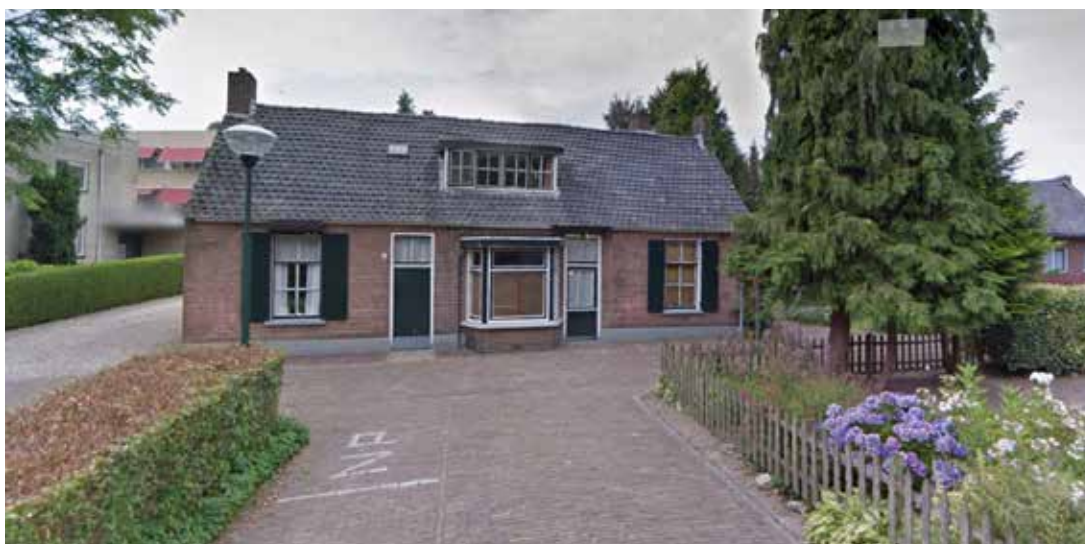
Kerkdijk 6 en 8, toegankelijk pannendak voor gierzwaluwen en huismussen.
