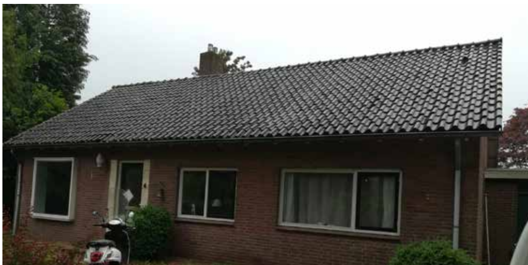
Kerkdijk 4, toegankelijk pannendak voor gierzwaluwen en huismussen.
