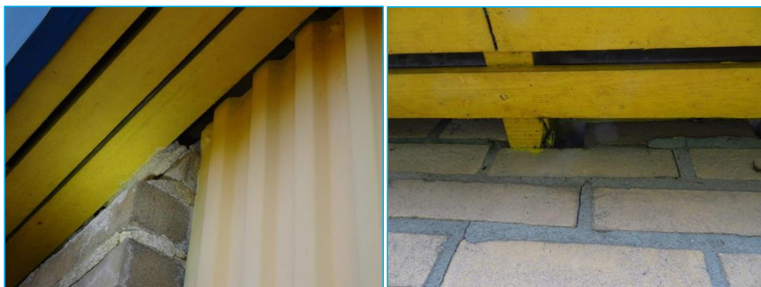
Foto's: Openingen school A en fietsenstalling die toegang kunnen bieden naar vaste verblijfplaatsen van vleermuizen.
