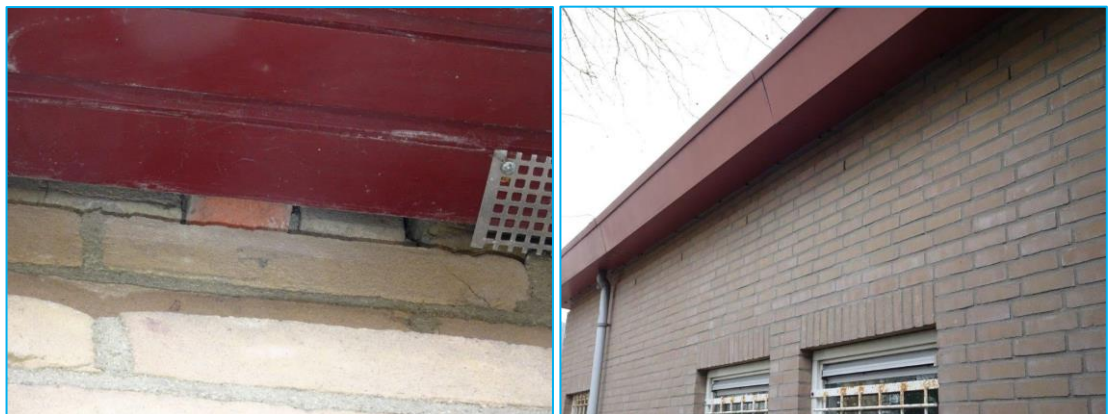
Foto's: Openingen/ stootvoegen die toegang kunnen bieden naar vaste verblijfplaatsen van vleermuizen.
