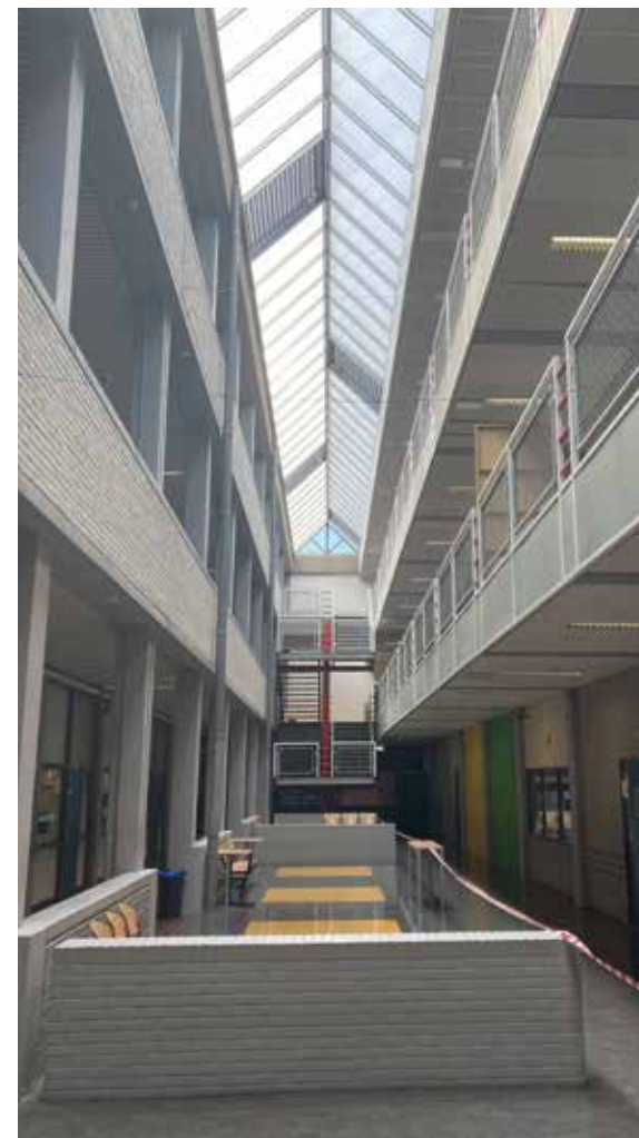
De huidige vide met daaromheen de open galerijen is gecreëerd door de toevoeging door de aanbouw rechts. Links de oude theorievleugel uit 1970.
