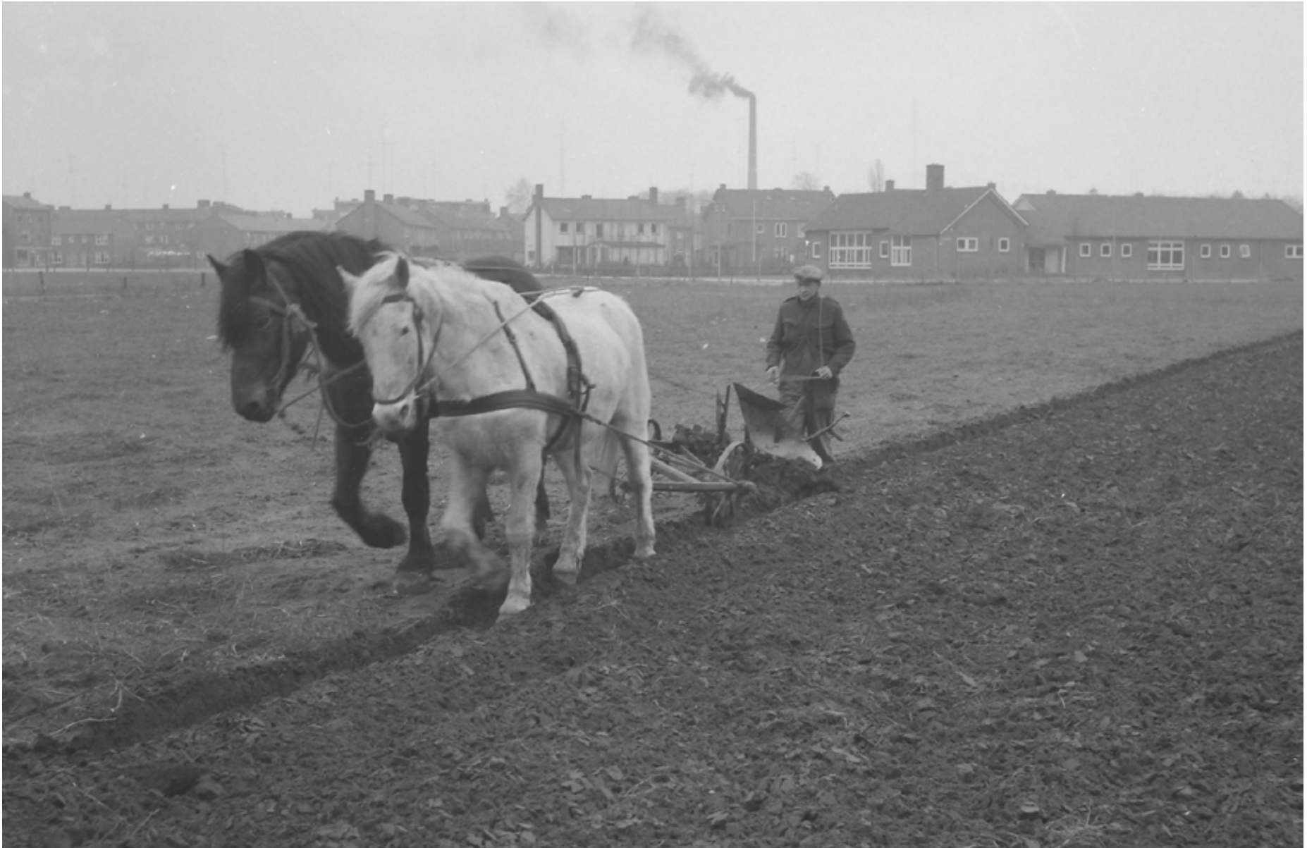
Boer Jos van de Beek bewerkt de grond waarop enkele jaren later het Ludgeruskwartier gebouwd zou gaan worden. Op de achtergrond de schoorsteen van vleeswarenfabriek Anton Hunink.
