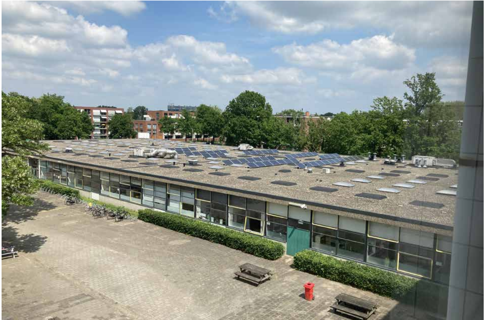
De brede éélaagse praktijkvleugel met plat dak en een gevel van gekoppelde ramen.
