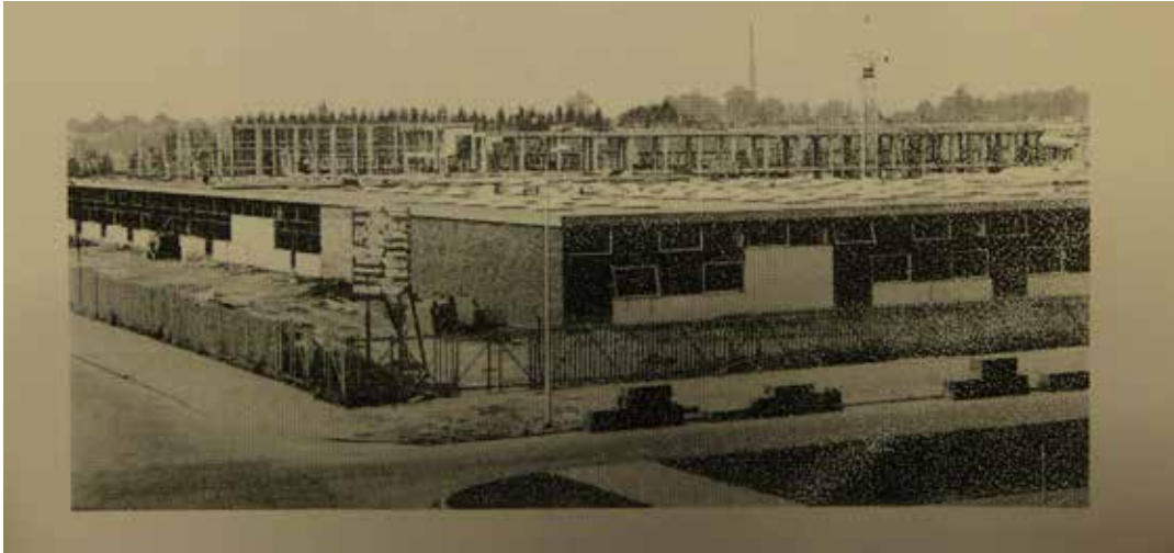
1969, Gedenkboek 75 jaar Gemeentelijke Technische School: Bouwwerkzaamheden in 1969 aan het schoolgebouw door Bouwbedrijf Obdeyn uit Deventer.
