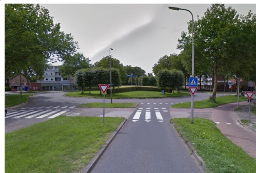
Figuur 4: Rotonde Zwolseweg-Ceintuurbaan (vanaf oostelijke tak)
