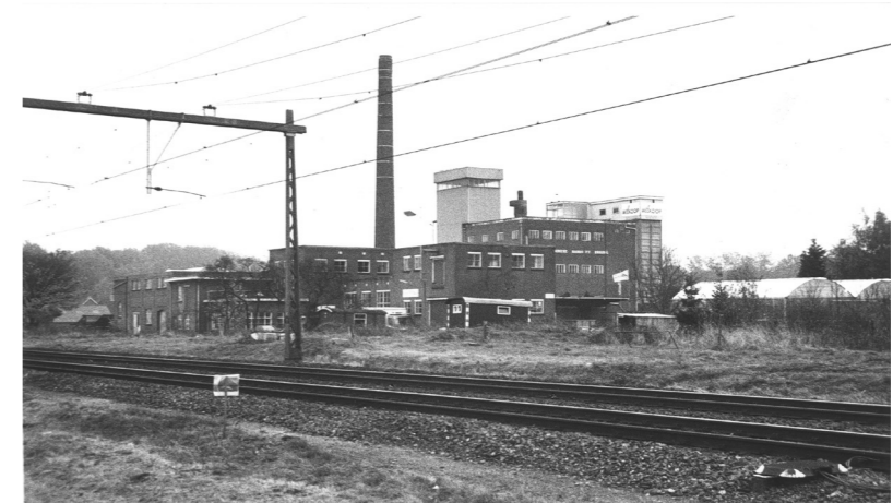
foto van zuivelfabriek uit eerste helft van 20 e eeuw gezien vanuit de spoorzone
