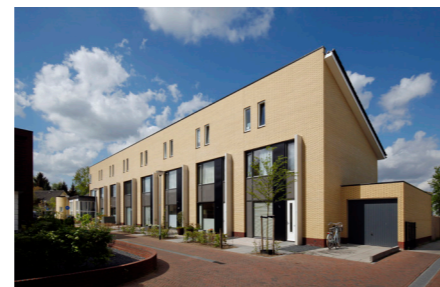
strakke architectuur & gele gevelsteen
