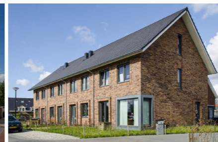
accenten in metselwerk
