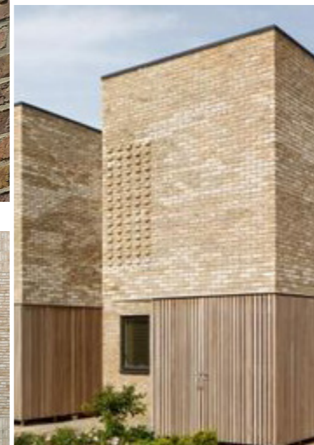
heldere indeling geve, donkere kozijnen en verfijning in gevelmetselwerk. accent in echte houten delen is mogelijk.
