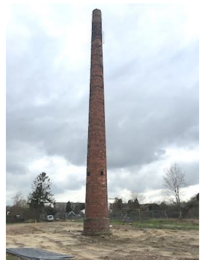
Figuur 8. Resterende schoorsteen.
