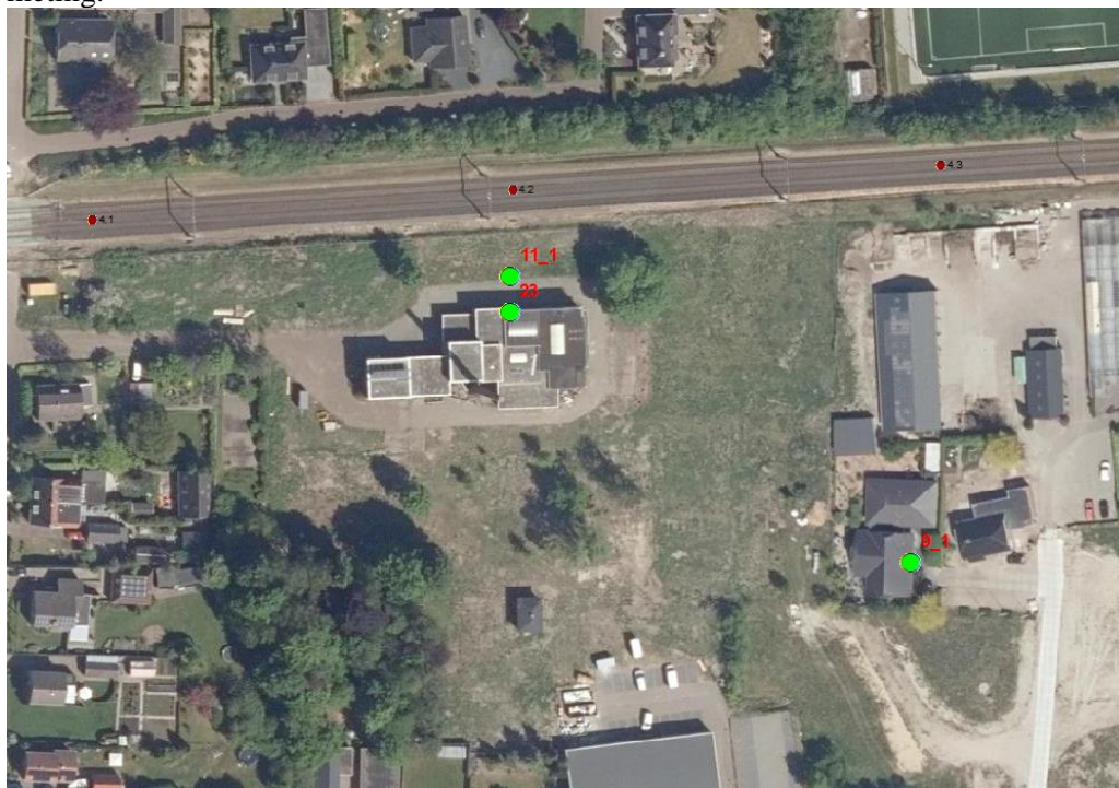
Figuur 2-2 Locatie van de meetlocatie met de meetpunten van de tweede meting
