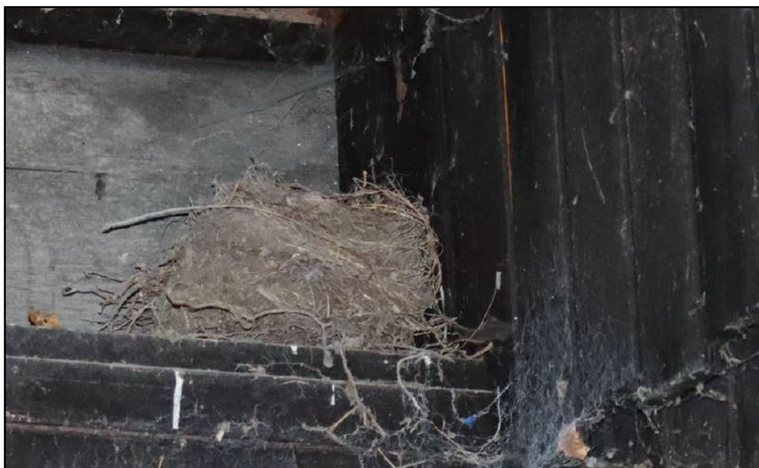
Figuur 4.2: Merelnest op een richel aan de achterzijde van de opslagruimte. Foto's: Ecogroen.
