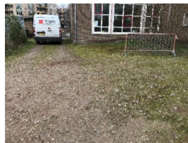
foto 3 - halfverhardingslaag met puin ter plaatse van boring 12
