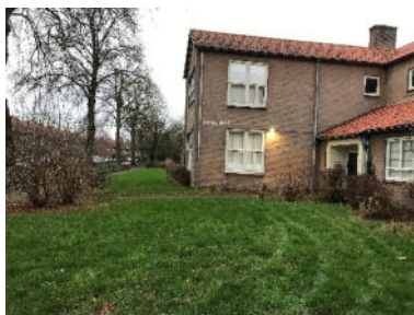
foto 2 - Van Hetenstraat 59 (ter plaatse van boring 08)
