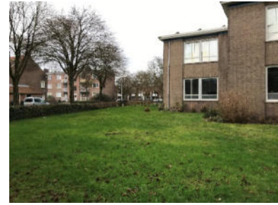
foto 6 - ter plaatse van Van Hetenstraat 57 (boring 27)
