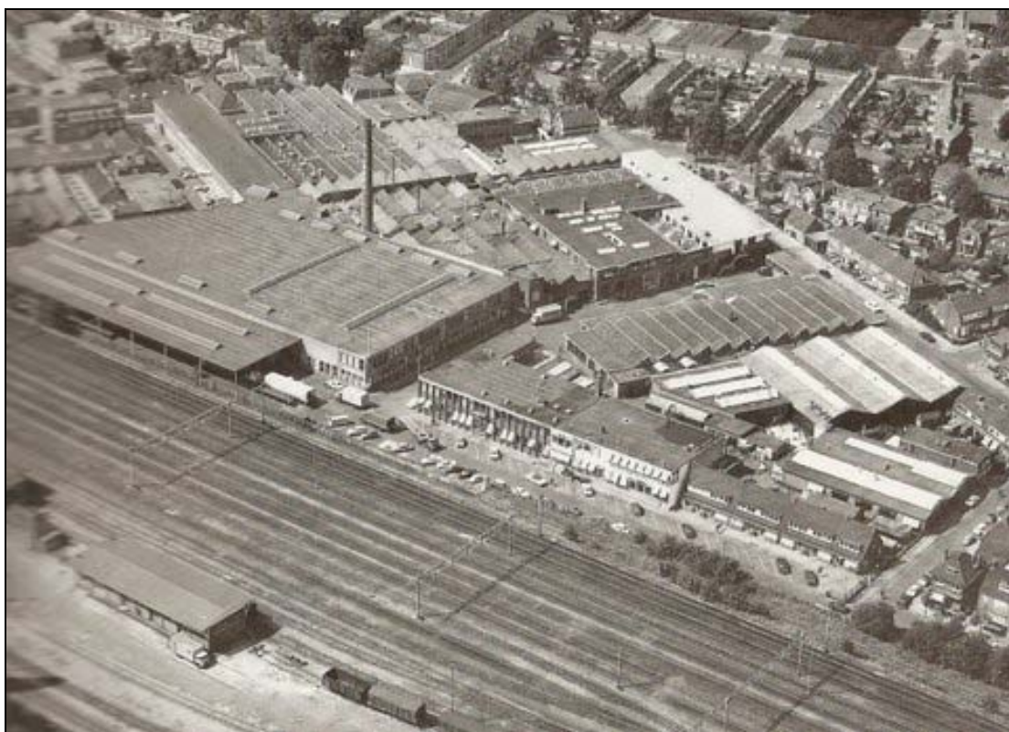
Figuur 2.6 Luchtfoto van het Thomassen & Drijver terrein (complex Deventer Centrum) omstreeks 1960. De foto is genomen in noordwestelijke richting. Ten zuiden van de plangebied ligt het brede rangeerterrein van het station en de spoorlijn. Ten tijde van deze foto was vrijwel het gehele plangebied bebouwd.
