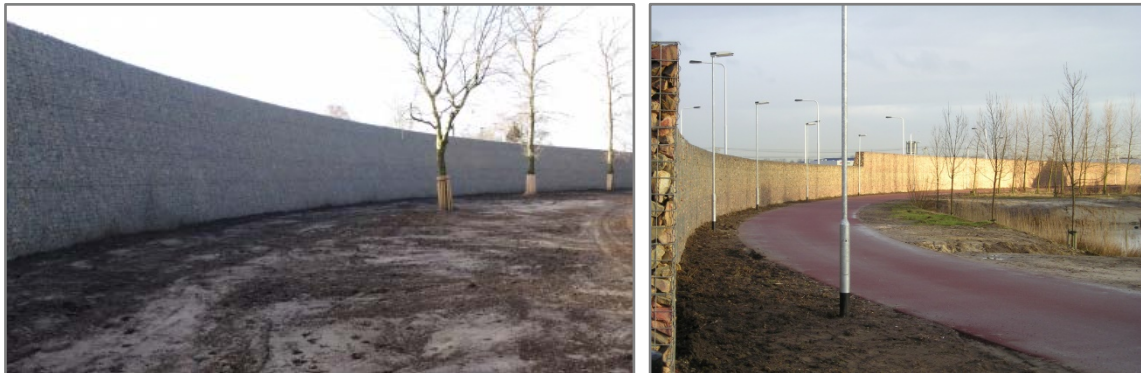
Figuur 3.3 Voorbeeld geluidsscherm schans-/ steenkorven
