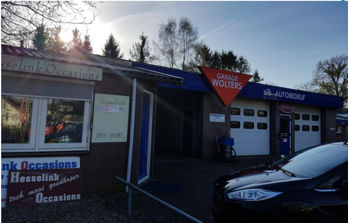
Figuur 2.2. Te slopen garagebedrijf binnen de onderzoekslocatie.
