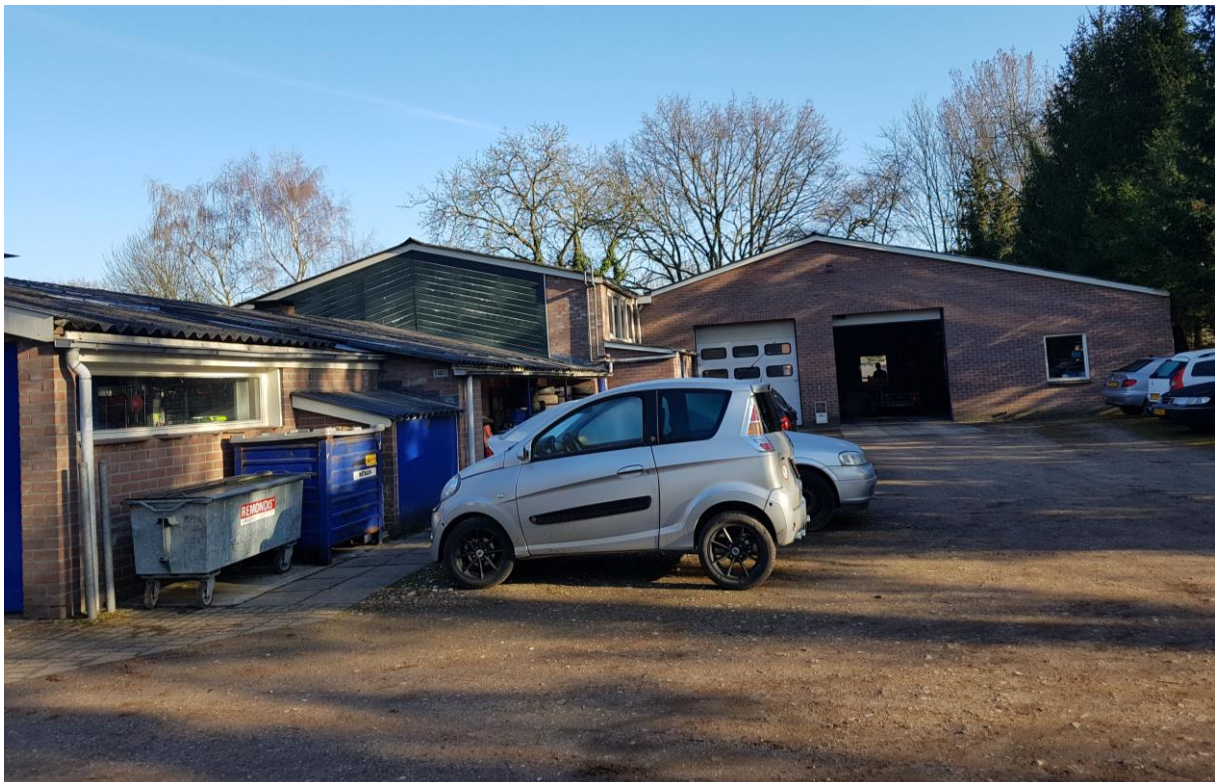
Figuur 2.3. Te slopen garagebedrijf binnen de onderzoekslocatie.
