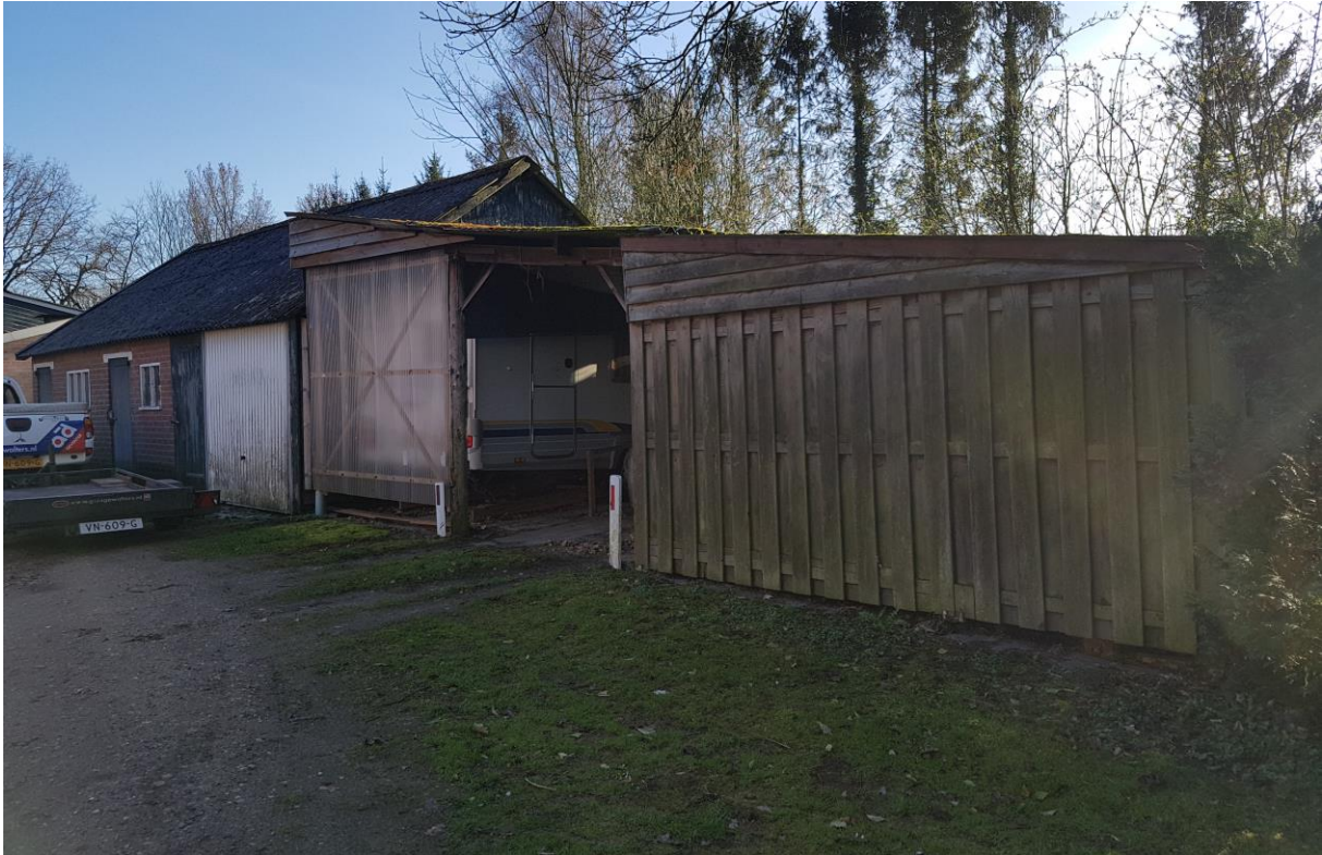
Figuur 2.4. Te slopen schuren binnen de onderzoekslocatie.
