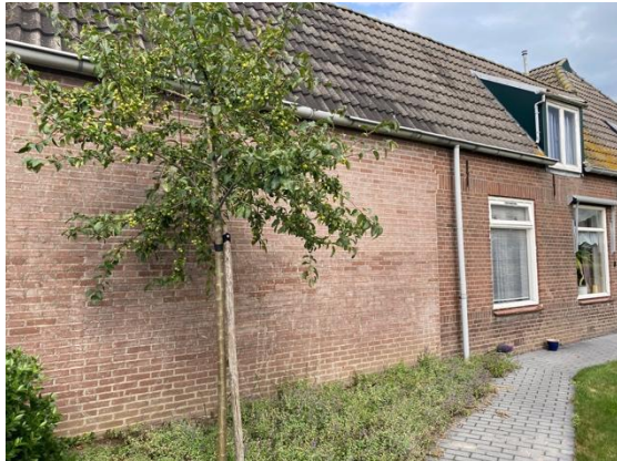
Afb. 3.4. Te amoveren aanpalende varkensschuur
