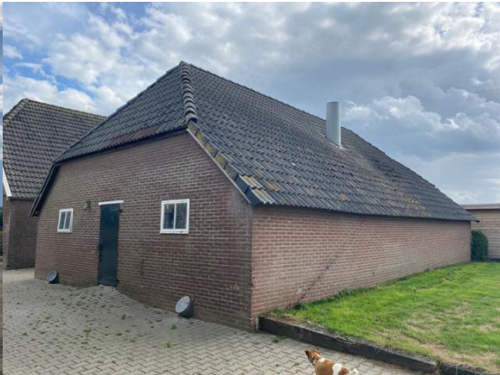
Afb. 3.9. Te amoveren aanpalende varkensschuur
