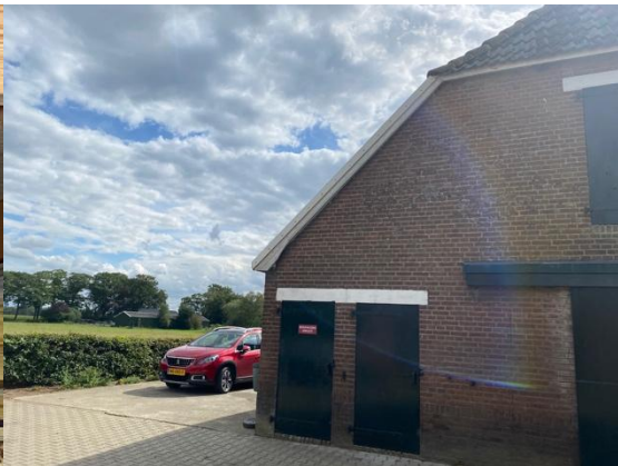
Afb. 3.11. Te behouden schuur en woongedeelte
