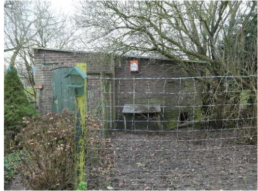
Figuur 3, foto van de te slopen schuur
