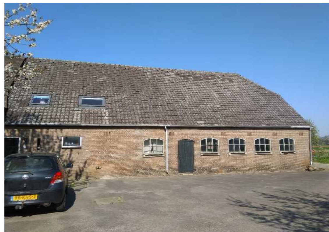
Bestaande gevel-dak oostzijde
