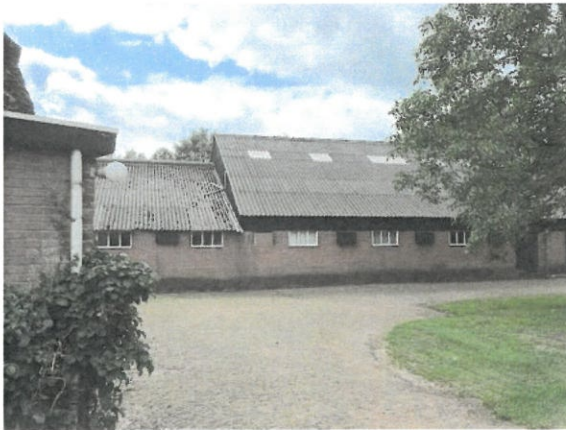
Figuur 3. Gebouw nr. 1 oostgevel.
