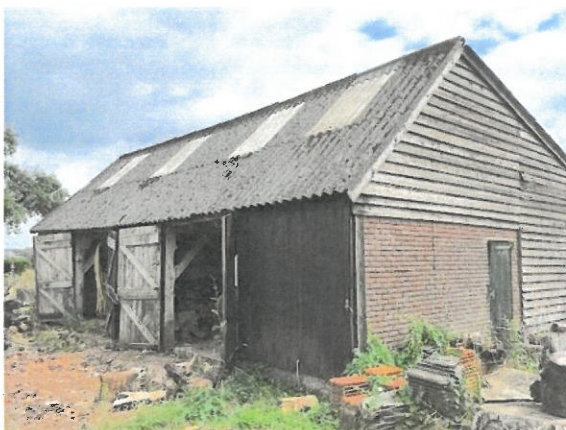
Figuur 5. Gebouw nr. 2.
