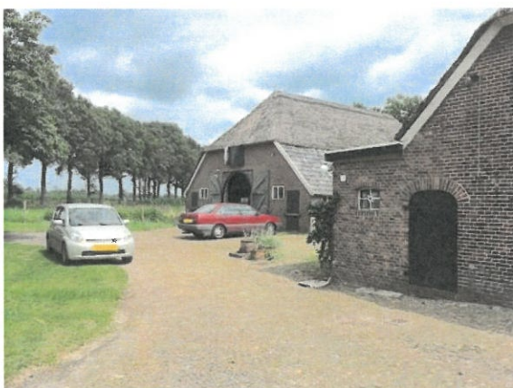
Figuur 7. Gebouw 4 (l) en 5
