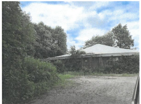
Figuur 6. Gebouw nr. 3.
