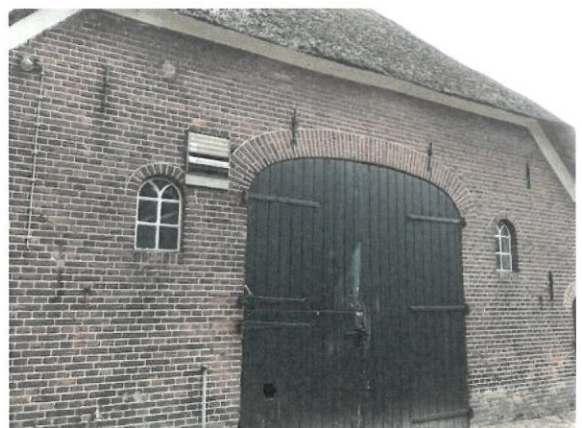
Figuur 8. Gebouw 5 nw-gevel
