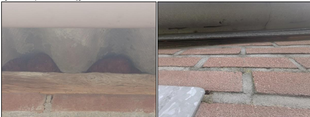
Figuur 2.4: De daken van de bijgebouwen met gemetselde gevels zijn grotendeels afgesloten; Figuur 2.5: Impressie van de daklijsten, welke goed op de gevel aansluiten.
