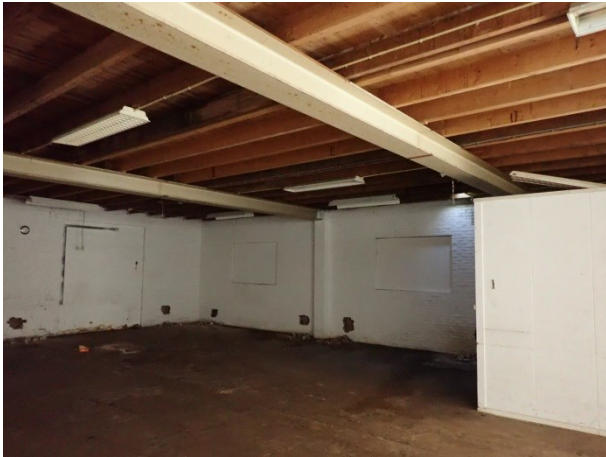
Foto 5: interieur. De balken met daarop de planken van het dak zijn goed zichtbaar.
