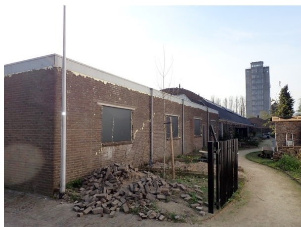
Foto3: loods aan westzijde, zijde van de binnentuin. De strook grond langs de loods wordt aangekocht en behoort tot het plangebied.
