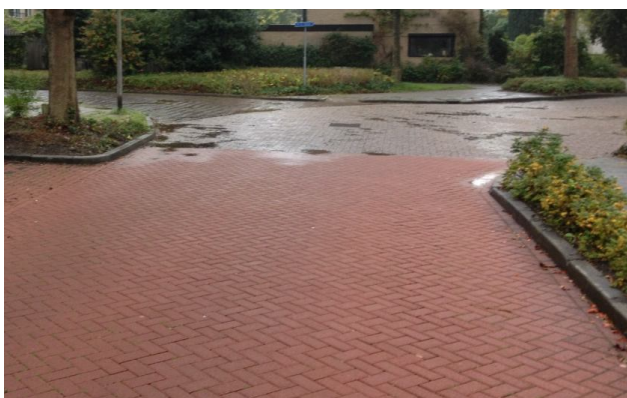
Figuur 2: Overgang infiltrerende naar conventionele verharding
