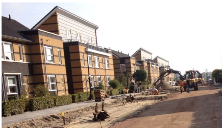
Figuur 30: Trottoir is voor de verharding aangelegd
