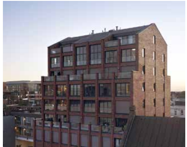
Herbestemming Twentse Schouwburg, binnenstad Enschede: de beëindiging verwijst de naar het silhouet van de oude schouwburg (Bron: De Zwarte Hond)
