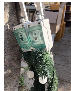
Figuur 1 Aanbrengen aardlekschakelaar
