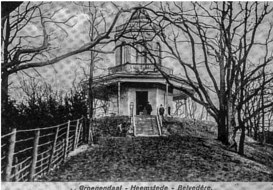
Figuur 1.1 De voormalige Belvédère (Bron: Heemstede.nieuws.nl)
